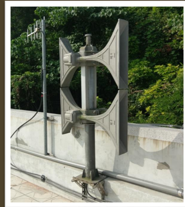
電子式警報器： 透過微控制器使電 路板產生警報音頻
